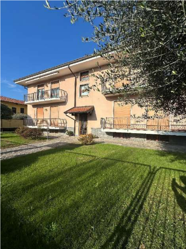
Foto della facciata sud
