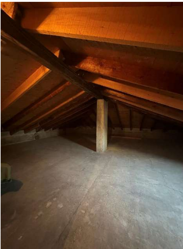
Foto del sottotetto
